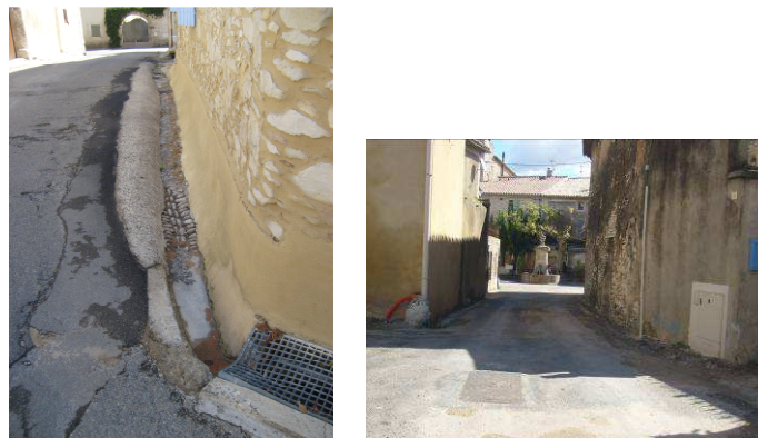
Illustration 8 : Vues du centre du village rue Baron Leroy (sous BV 3)
