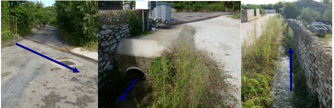
Illustration 15 : Traversée du chemin du Chantegrillet par le Chantegrillet (sous BV 5)
