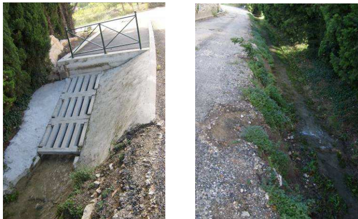
Illustration 16 : Traversée de la RD26 par le Chantegrillet au droit du cimetière (sous BV 5)
