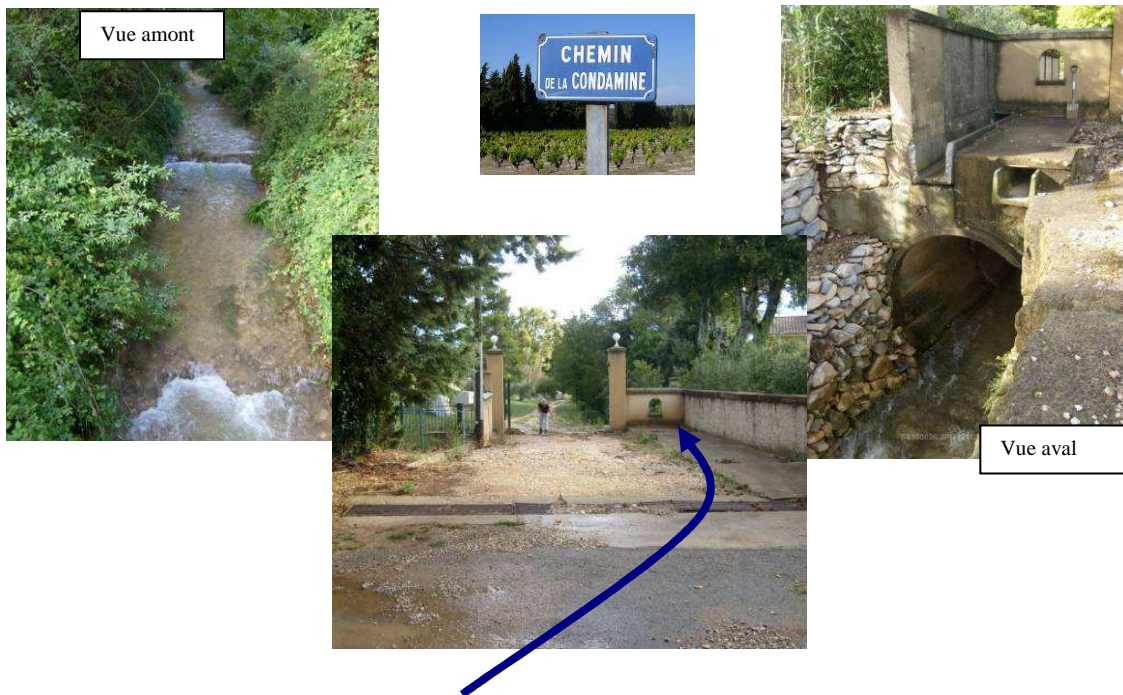
Illustration 12 : Cours du Nizon au droit de sa traversée sous le chemin de la Condamine (sous BV 4)
