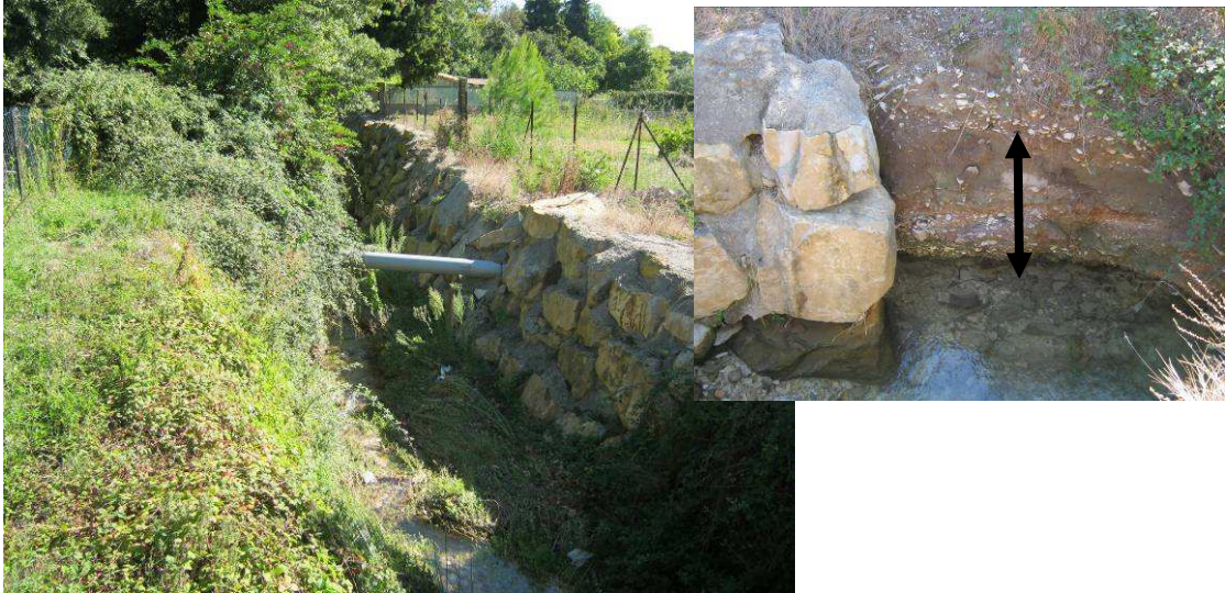
Illustration 11 : Abaissement du lit du Nizon en aval de la RD26 (sous BV 4)
